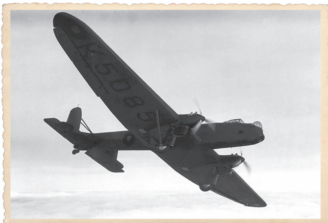
Le Fairey Hendon, entré en service en 1934, est le premier bombardier britannique de construction entièrement métallique. Doté de postes d'équipage ouvert et d'un train d'atterrissage fixe, il apparaît pourtant très vite obsolète.
