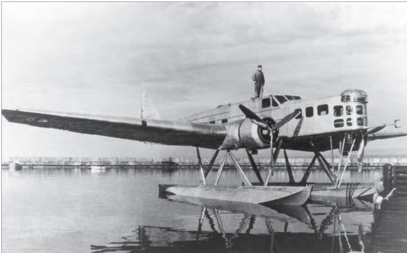
Fin 1935, le train d'atterrissage fixe du prototype du Bloch 210 est remplacé par des flotteurs, puis il est transporté en pièces détachées à Marignane pour y être remonté et essayé avec deux Gnome-Rhône 14 Kirs/jrs de 870 ch.
