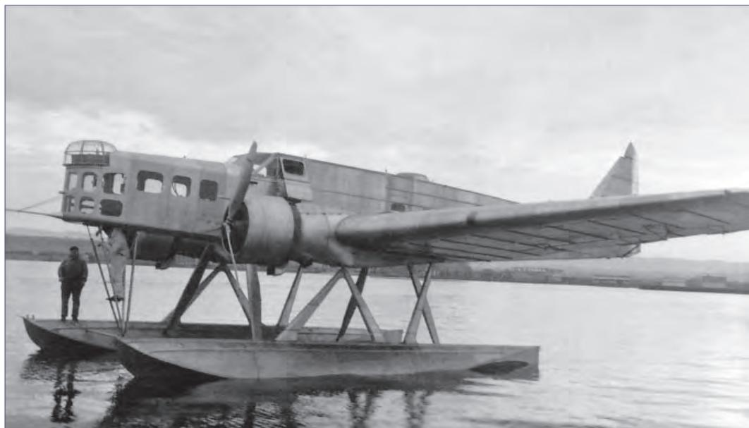
*Le pilote prend place à bord en passant par une trappe placée sous le nez, accessible par une échelle amovible en avant des mâts de fixation des flotteurs.*
