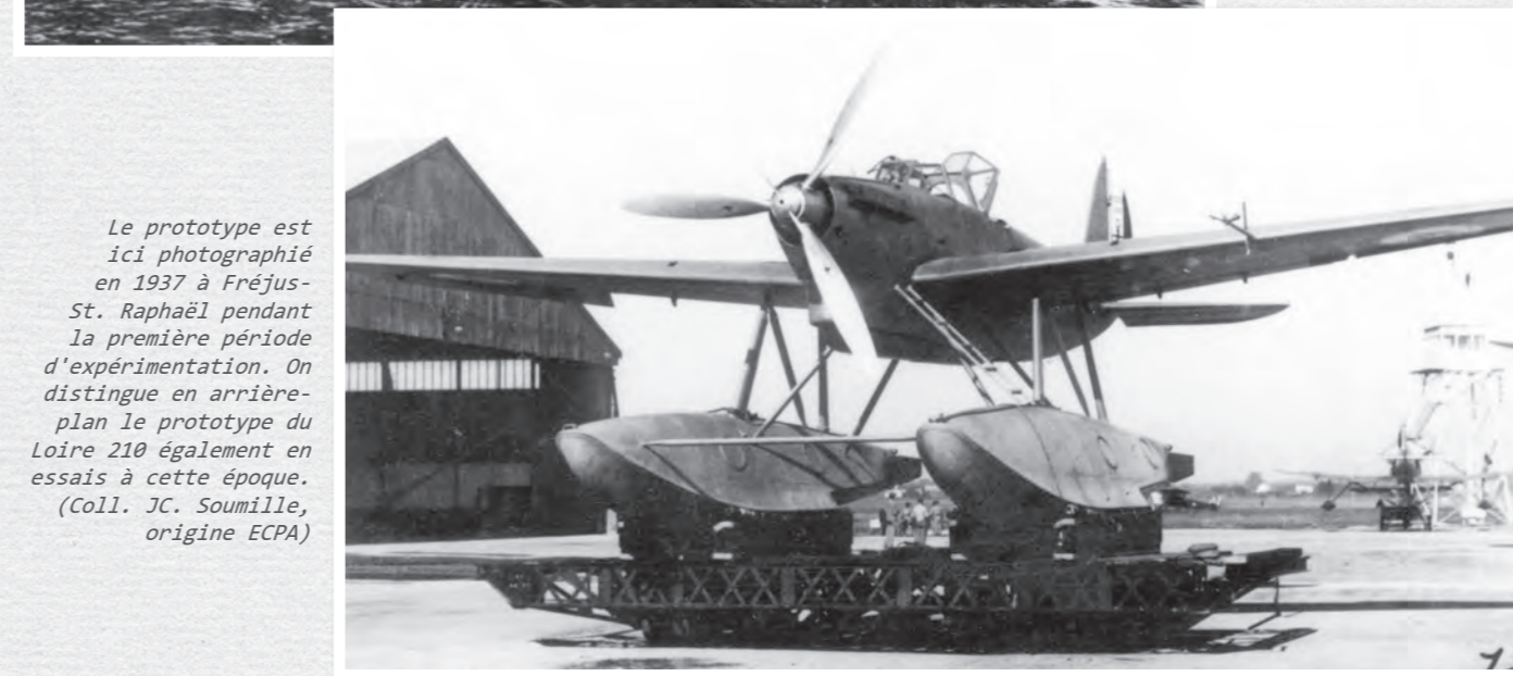
Le Latécoère 298 N° 01 photographié fin 1936 ou début 1937 à Fréjus-Saint-Raphaël lors de la première séance d'épreuves à la CEPA. La verrière d'origine à la visibilité réduite sera l'un des rares changements qui sera demandé par la Marine. (Coll. JC. Soumille)
